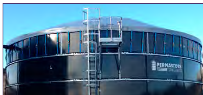
6: Cobertura em PVC – Espanha
