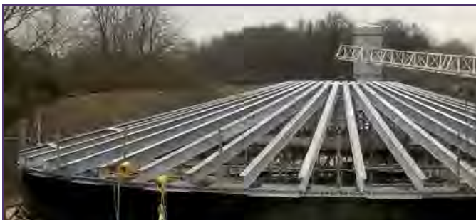
3: Techo Cónico de Viga Externa – Digestión Anaerobia y Biogás
